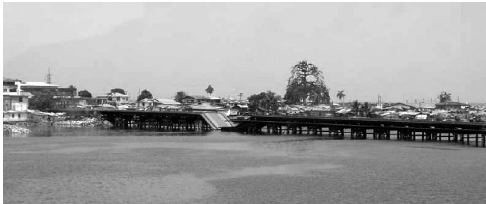
Die zerstörte Mesurado-Bridge in Monrovia: Symbolik einer ungewissen Zukunft.
