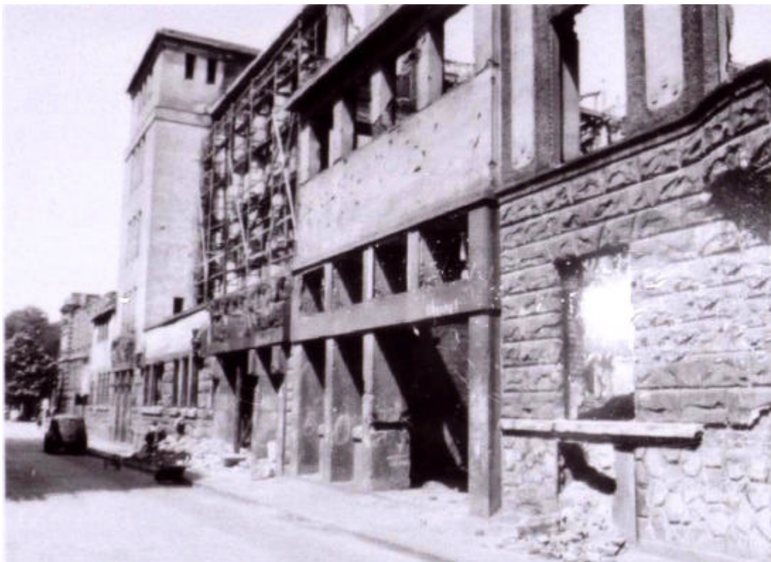
Wohlfahrtshaus der Stadt Cöln mit kommunalem Arbeitsnachweis 1910 (oben) und 1945 (unten) Quelle: Historisches Archiv Köln und Rheinisches Bilderarchiv Köln
