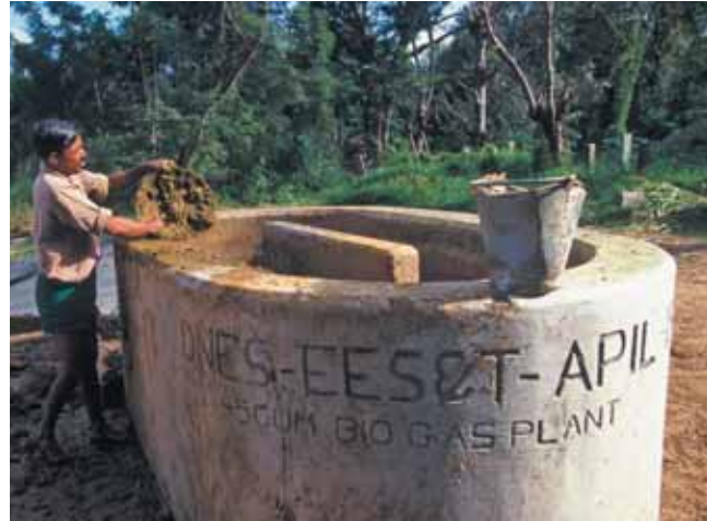
Bau einer kleineren Biogasanlage, die mit Kuhdung befeuert wird. Etliche Regierungen ärmerer Länder wie in Nepal haben erkannt, dass diese Form der regenerativen Energieerzeugung viele Vorteile bringt. Foto: Mark Edwards/Still Pictures
